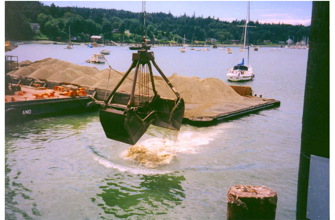
Đặt vật liệu bằng xô mở
