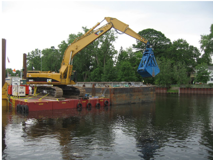
Excavador hidráulico con balde cerrado
