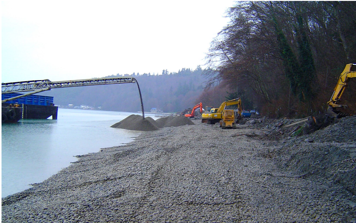
Retirando material usando una cinta transportadora
