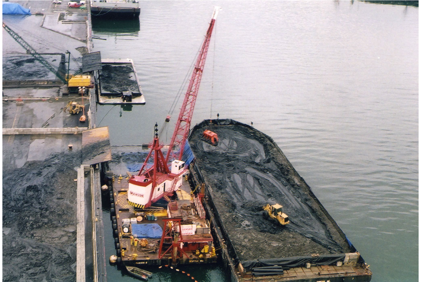
Bajando material dragado con un balde cerrado y plataforma para evitar derramar el material
