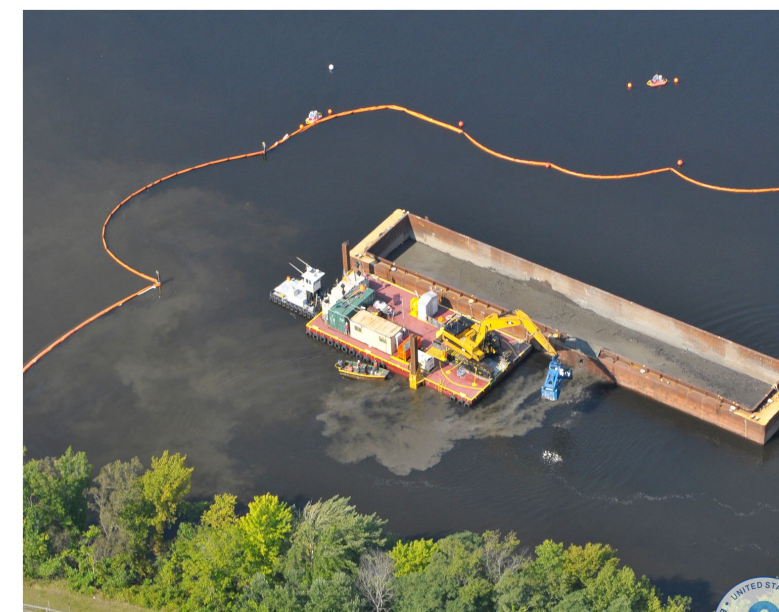
Excavador hidráulico en barcaza flo
