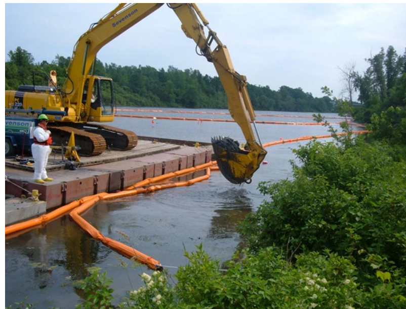
Excavador hidráulico con balde abierto
